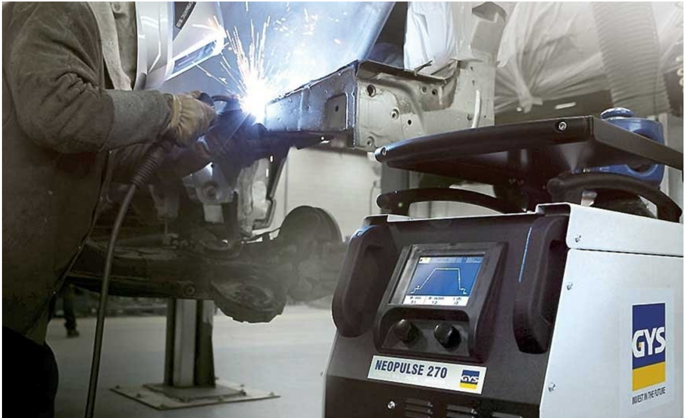
Lutospawanie karoserii ze stopów stalowych (fot. GYS.pl)
