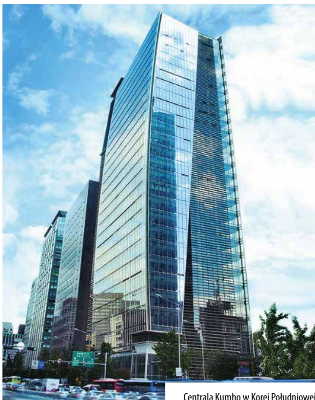
Centrala Kumho w Korei Południowej
