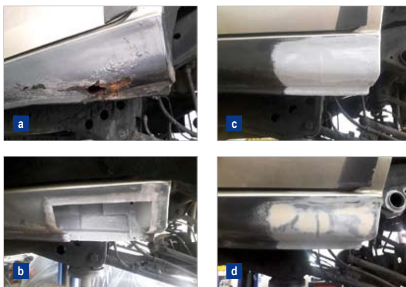
Rys. 4. Kolejne kroki naprawy progu (fot. Iron Garage Jeleśnia): a) przedziewiela na wskroś próg przed rozpoczęciem prac blacharskich; b) po wycięciu zardzewiałych miejsc, oczyszczeniu i zabezpieczeniu antykorozyjnym w środku profilu; c) po naprawie blacharskiej i zabezpieczeniu antykorozyjnym na zewnątrz profilu; d) po wyrównaniu ubytków za pomocą szpachłówki poliestrowej
