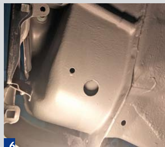
6 Nadkole pomalowane podkładem epoksydowym
