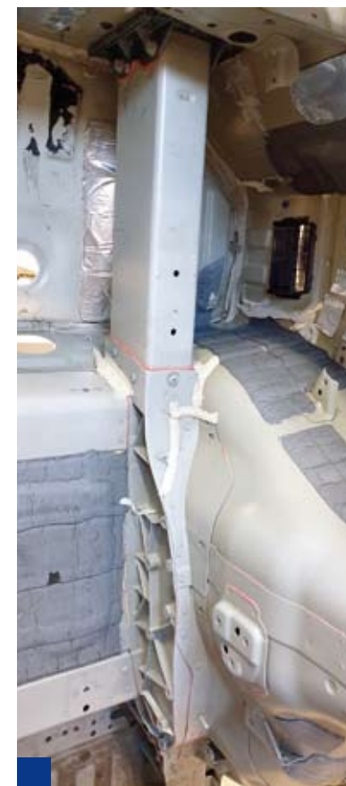
Połączenie za pomocą klejenia i nitowania odlewu ciśnieniowego wykonanego ze stopu aluminium oraz elementów z blachy aluminiowej (fot. BR)
