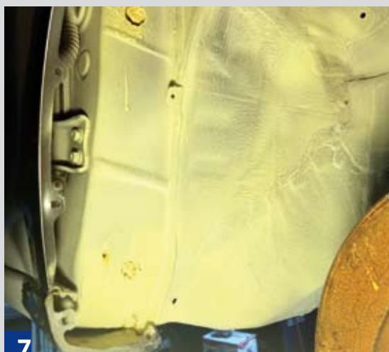
7 Nadkole zabezpieczone antykorozyjnie preparatem Mike Sanders Korrosionsschutzfett
