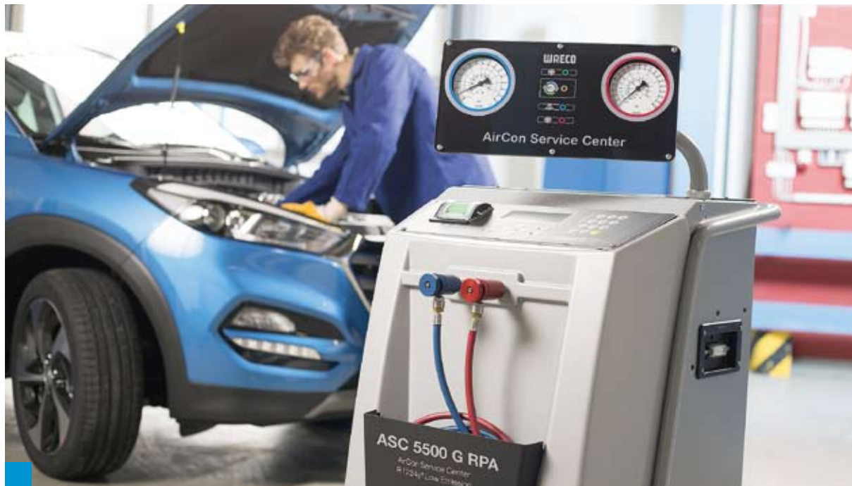
Zwiększona wilgotność może wpływać niekorzystnie na właściwości smarne oleju. To z kolei skraca żywotność podzespołów układu klimatyzacji. Warto o tym pamiętać podczas prac serwisowych
